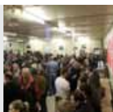
15 ottobre 2010 I due fronti del cantiere Alpransit si sono congiunti facendo cadere l'ultimo diaframma. Il giorno prima a Faido, Unia ha organizzato una festa per onorare i lavoratori che sono stati e saranno ancora impegnati in questa colossale impresa.
