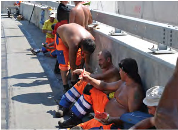
Zurich, chantier du Hardbrücke: la température dépasse les 40 degrés.
