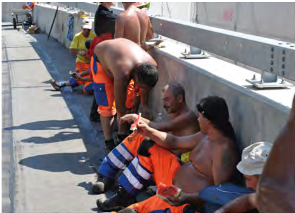
Zürich, Temperaturen über 40 Grad auf der Baustelle Hardbrücke.
