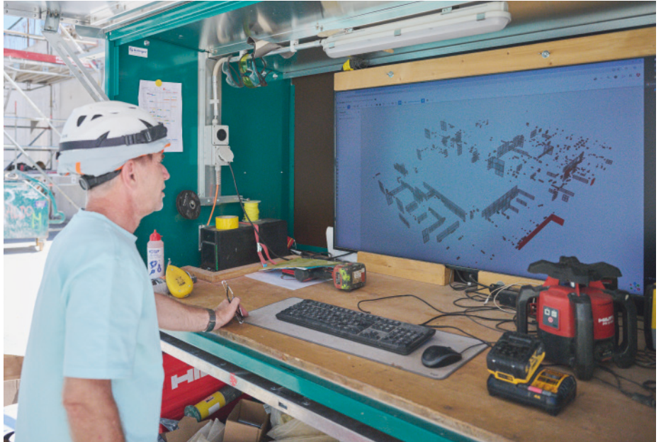
Sechs Planhäuser, null Papier: Auf dem Campus wird nach der BIM2Field-Methodik gebaut.
