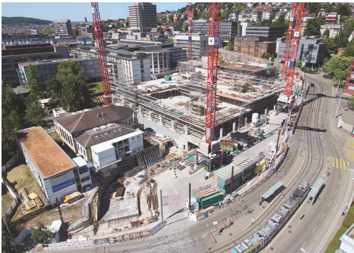
Enge Platzverhältnisse, anspruchsvolle Zufahrten, sensible Nachbarn: Die Baustelle Campus MITTE1|2 schliesst unmittelbar an die heutigen Spitalgebäude an. Foto: USZ
