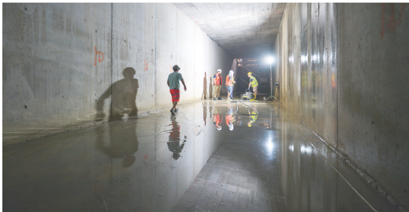
Schwimmende Bodenplatte: Um Auftrieb zu verhindern und Gewicht zu gewinnen, wurden die unterirdischen Luftkanäle mit Wasser gefüllt.
