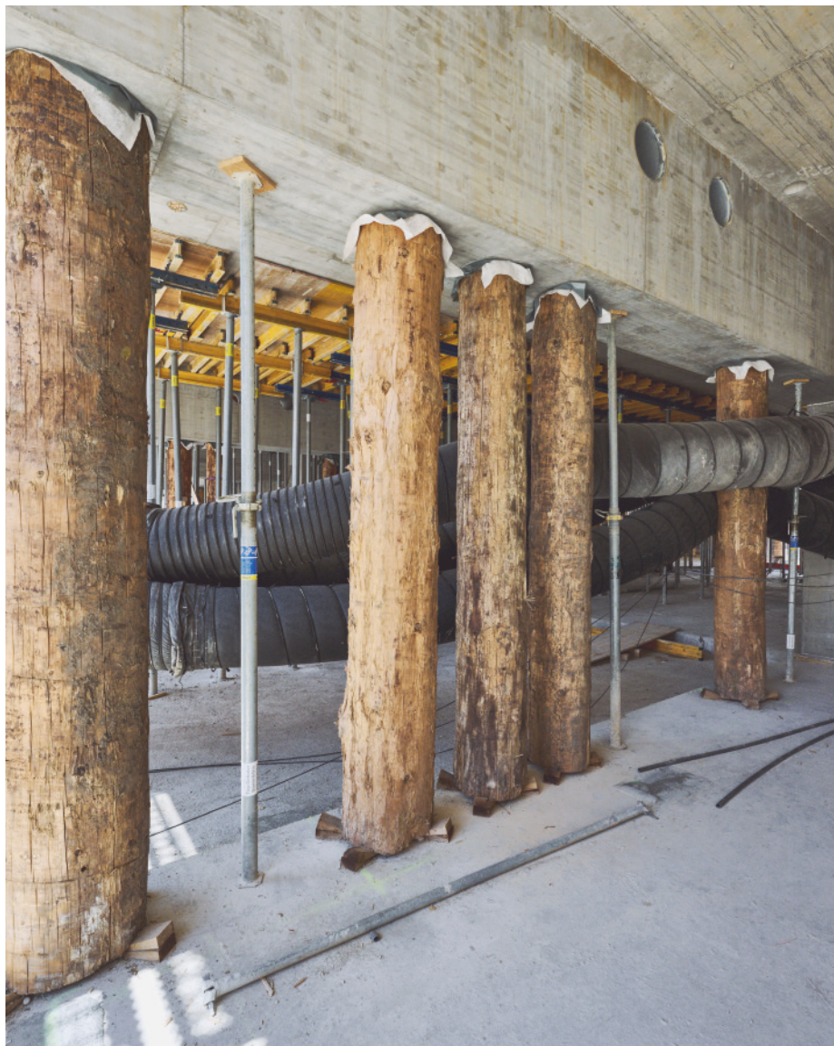
Natürliche Deckenstützen: Ein Stamm ersetzt bis zu zehn Stahlsprissen.
