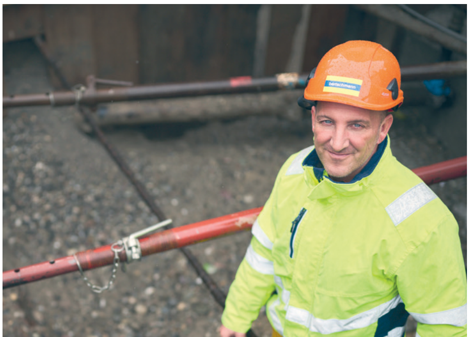
Von klein auf von Baggern fasziniert: Polier Ruben Vidal (43). Foto Manu Friederich
