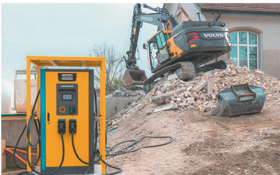
Auch der Einsatz von schweren Geräten hat sich bewährt: Pilotbaustelle in Zürich. Foto Julian Graf/Stadt Zürich, Amt für Hochbauten
