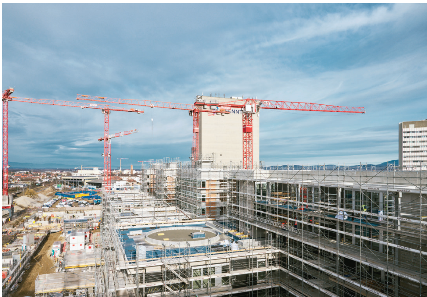
Blick von der Dachterrasse: Insgesamt werden 42 000 Kubikmeter Beton und über 5000 Tonnen Stahl verbaut.
