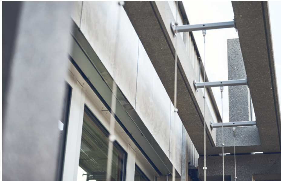
Fassaden-Mockup: Für das Betongrid müssen 1200 vorgefertigte Betonteile eingebaut werden.
