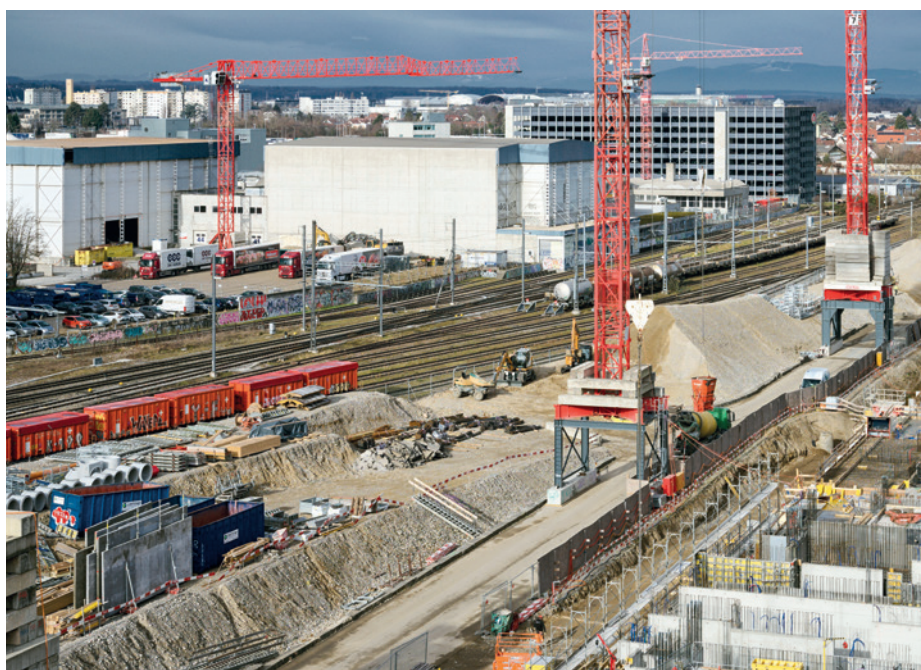
Zwischenraum zur Bahnlinie: Heute Lagerplatz für Aushub und Materialien, morgen ein naturnaher Park.
