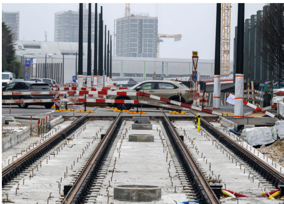
Une spécificité: le tram lausannois circule en voie métrique, tout comme les CFF.
