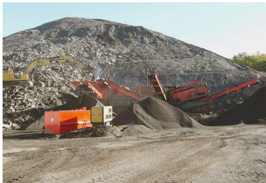
Gaspillage de ressources: chaque année, 750 000 tonnes d'asphalte d'excavation finissent dans des décharges.
