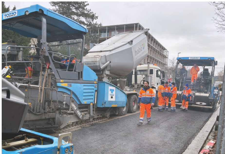
Asphalte avec du charbon végétal: Bâle utilise aussi avec succès ce mélange sur des routes très fréquentées. Ici la route de Freiburg.
