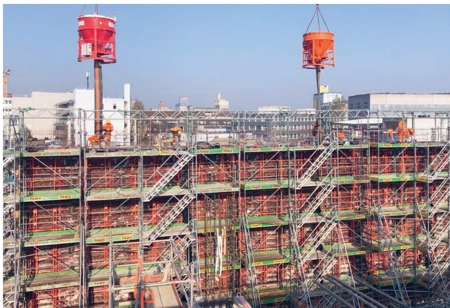
Construction du réacteur biologique
