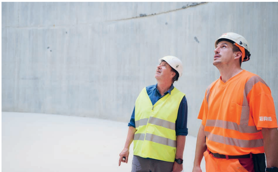
« Ici, il s'agit d'un travail foncièrement différent »: le chef contremaître Waldmeier (à droite) et le chef de chantier Bégue dans une tour de décomposition terminée. Photo: Manu Friederich
