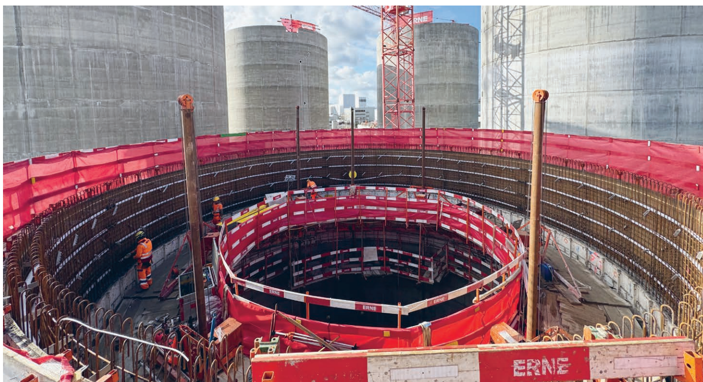
Tour de décomposition pour la production de biogaz: afin d'éviter les fissures, des câbles de tension ont été tendus en plus des armatures.
