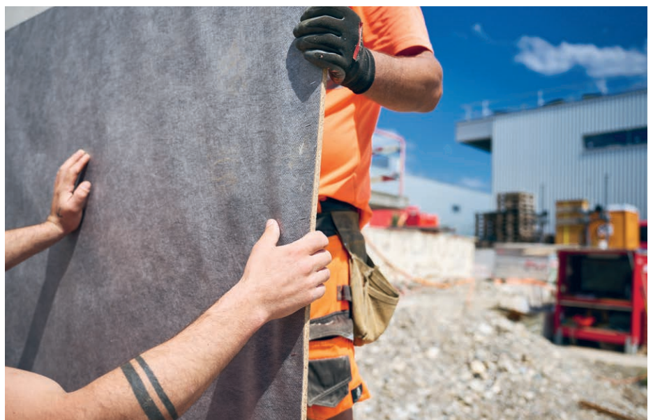
Film Zemdrain sur planche de coffrage. Photo Manu Friederich
