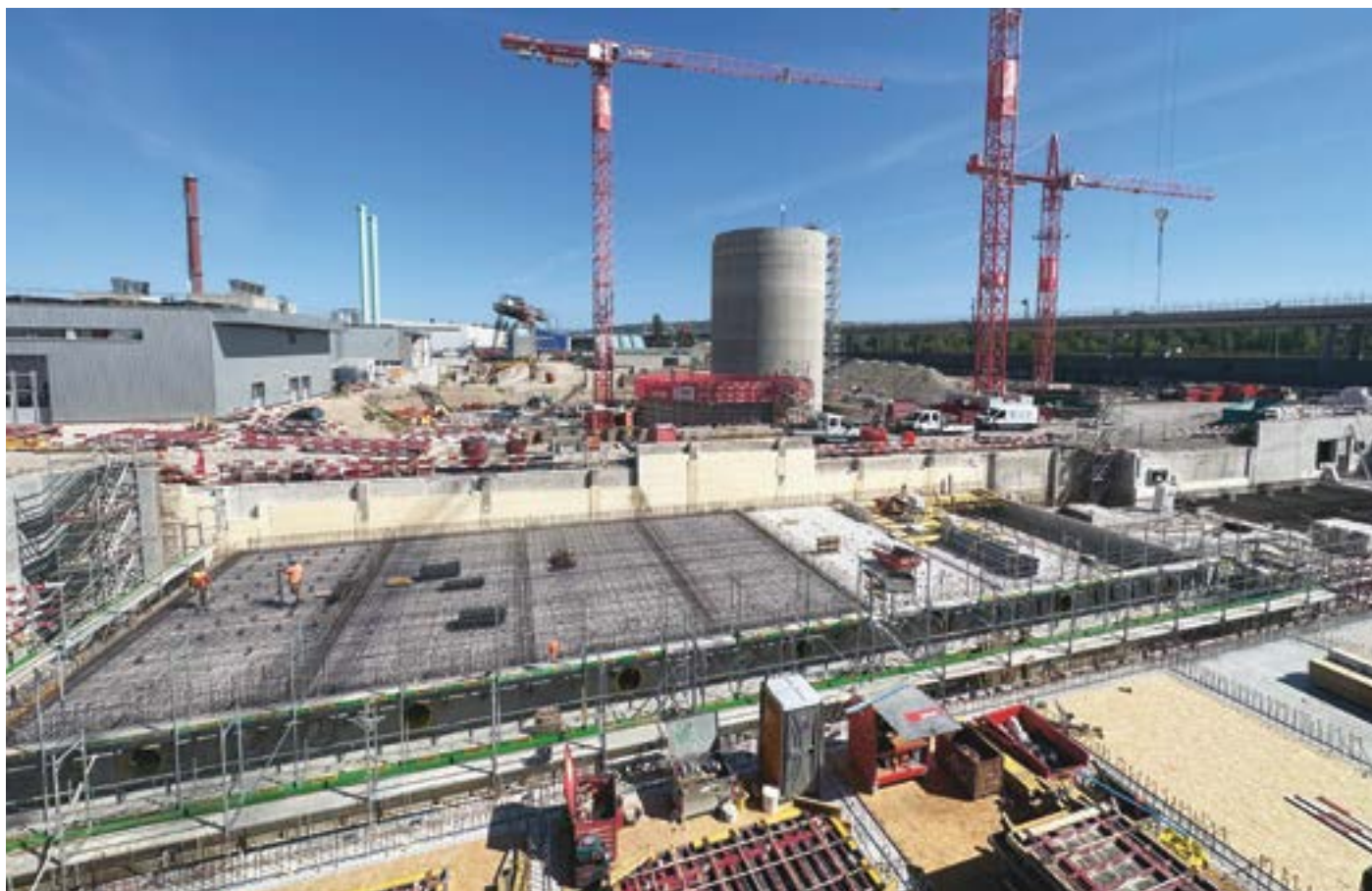
Komplexer Bau mit vielen Auflagen: Armierungsarbeiten für die neue Mikroverunreinigungs-Anlage, hinten einer der fünf Faultürme.
