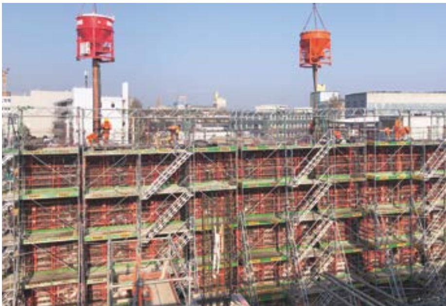
10 Meter hoch, 32 Meter lang, 70 Zentimeter dick: Bau der Reaktoren für die biologische Reinigung im einteiligen Verfahren.
