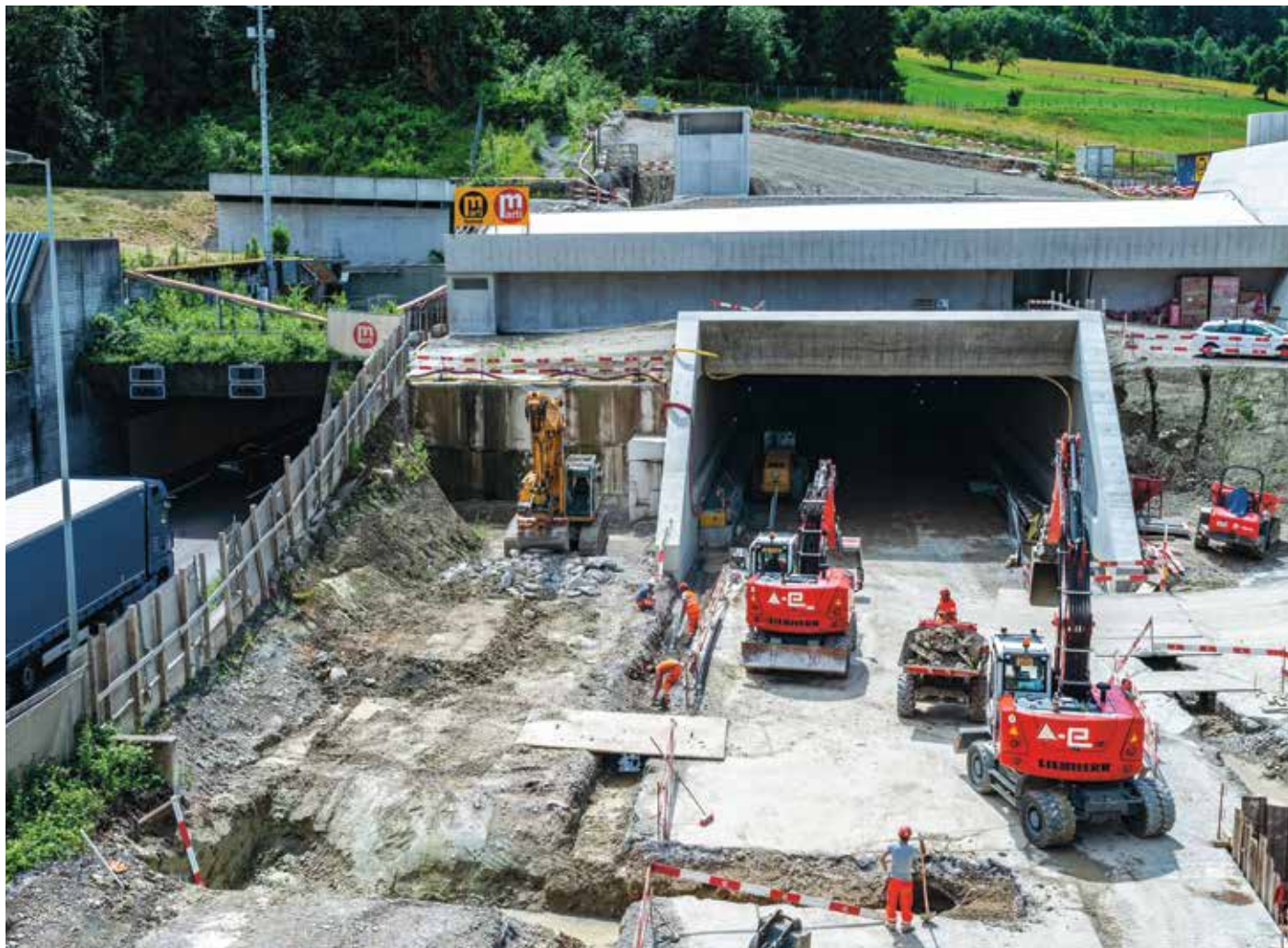
Grossbaustelle Zürich Nord: Die neue Röhre musste parallel zu einer der meistbefahrenen Autobahnen der Schweiz gebaut werden.
