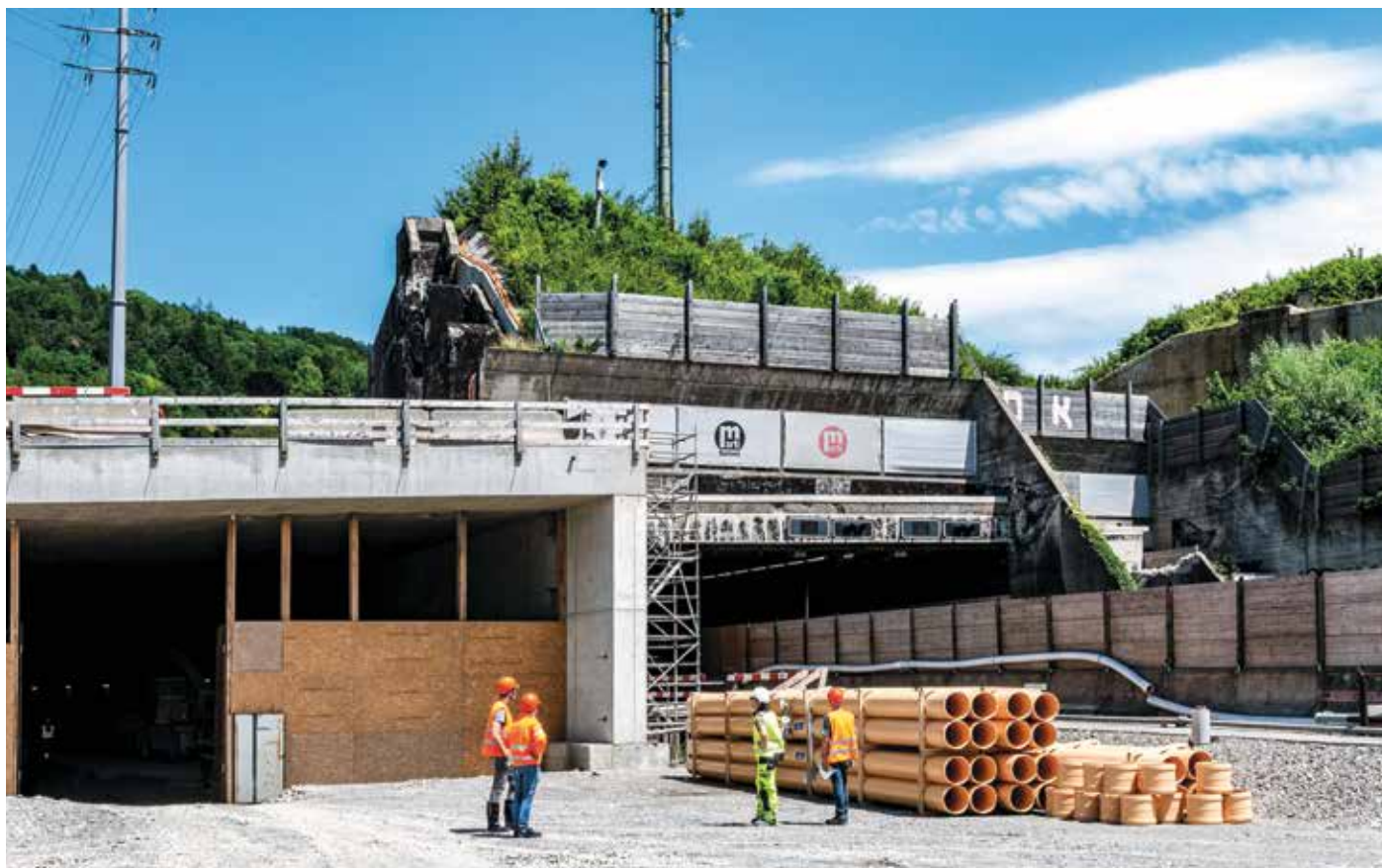
Um Platz für die dritte Röhre zu schaffen, musste ein halber Hügel abgetragen werden: Westportal bei Weiningen.
