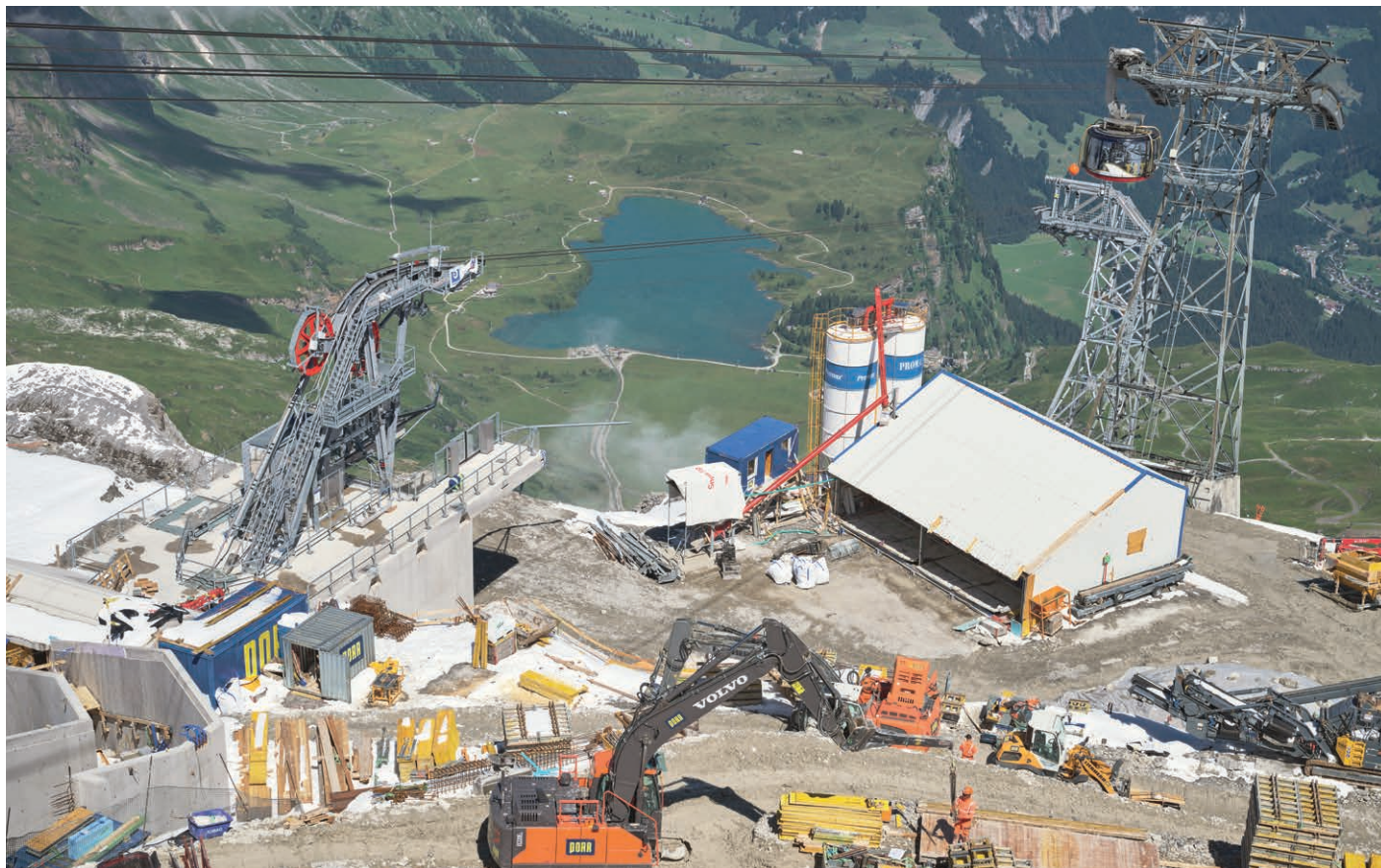
Peu de place : l'aire de stockage du matériel avec la station supérieure du nouveau téléphérique et la centrale à béton.
