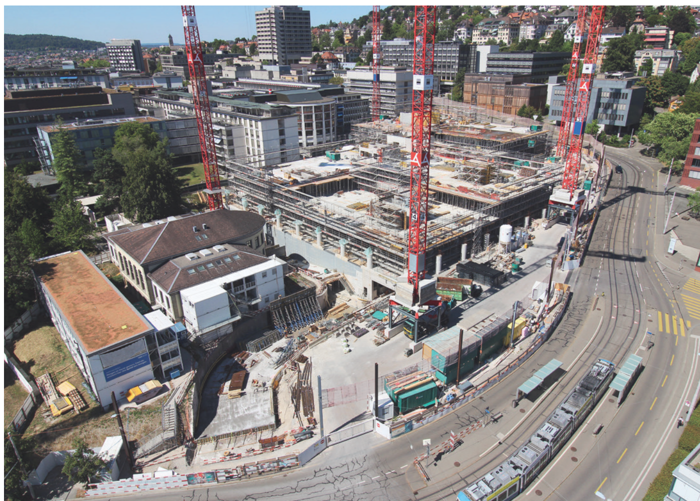
Espace restreint, accès difficiles, voisins sensibles: le chantier Campus MITTE1|2 est situé à côté des bâtiments actuels de l'hôpital. Photo: Hôpital universitaire de Zurich
