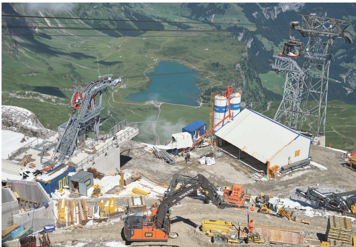
Engste Verhältnisse: Der Materialplatz mit der Bergstation der neuen Transportbahn und dem Betonwerk.
