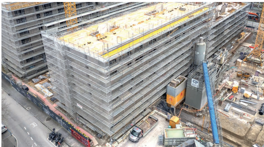
Modellbaustelle für nachhaltiges Bauen: Der Recyclinganteil im Beton beträgt bis zu 100 Prozent. Foto: Philippe Jaggi.
