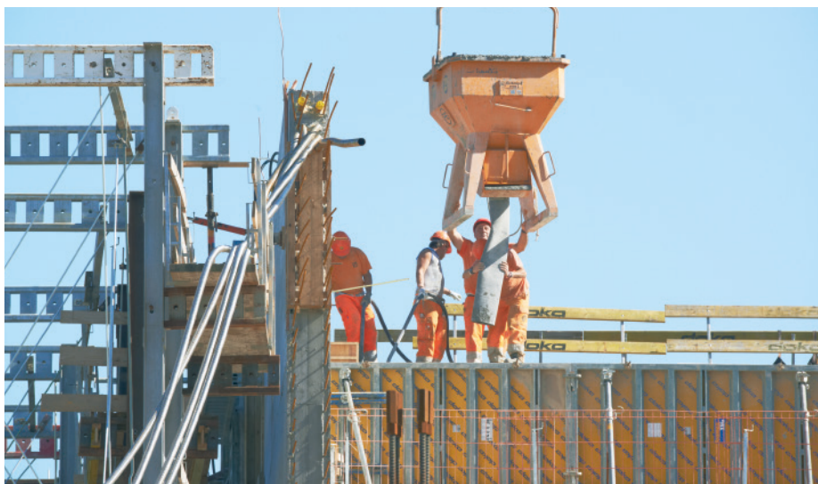
Garantie du pouvoir d'achat: les salaires minimaux et effectifs seront désormais adaptés annuellement en janvier. Photo: Unia.
