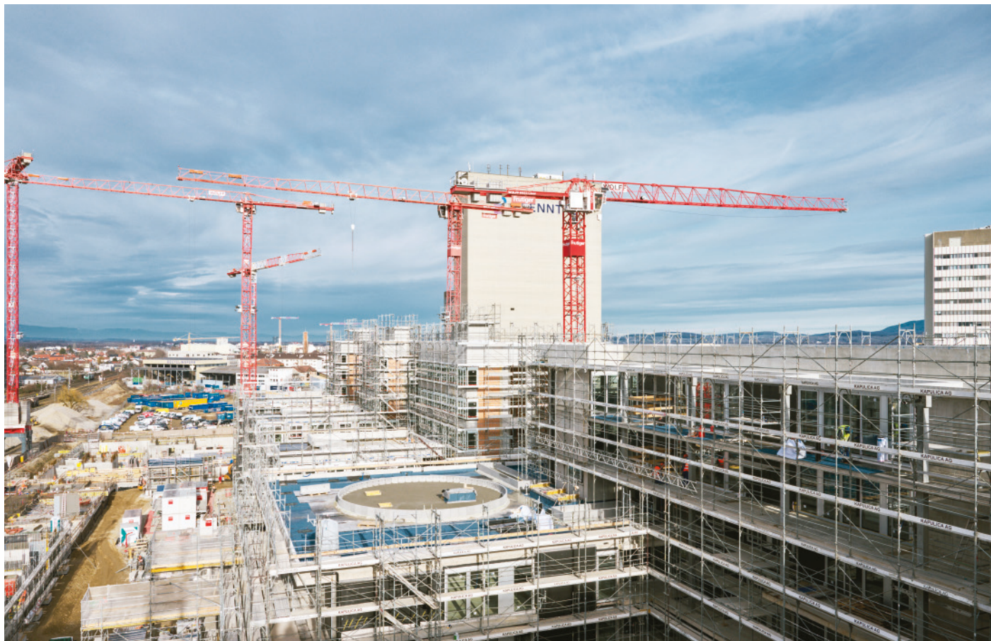
Vue depuis la terrasse sur le toit: au total, 42 000 mètres cubes de béton et plus de 5000 tonnes d'acier seront utilisés.
