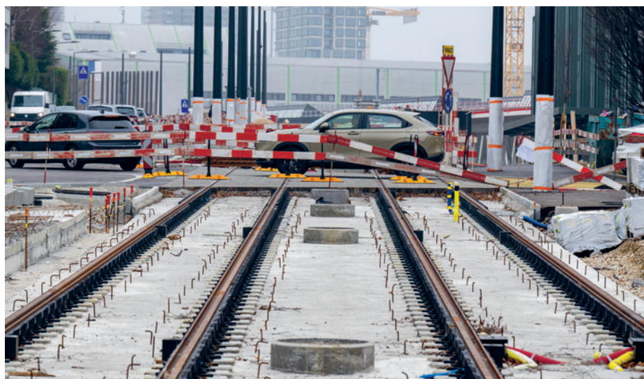
Spezialität: Das Lausanner Tram fährt auf der Spurbreite der SBB.
