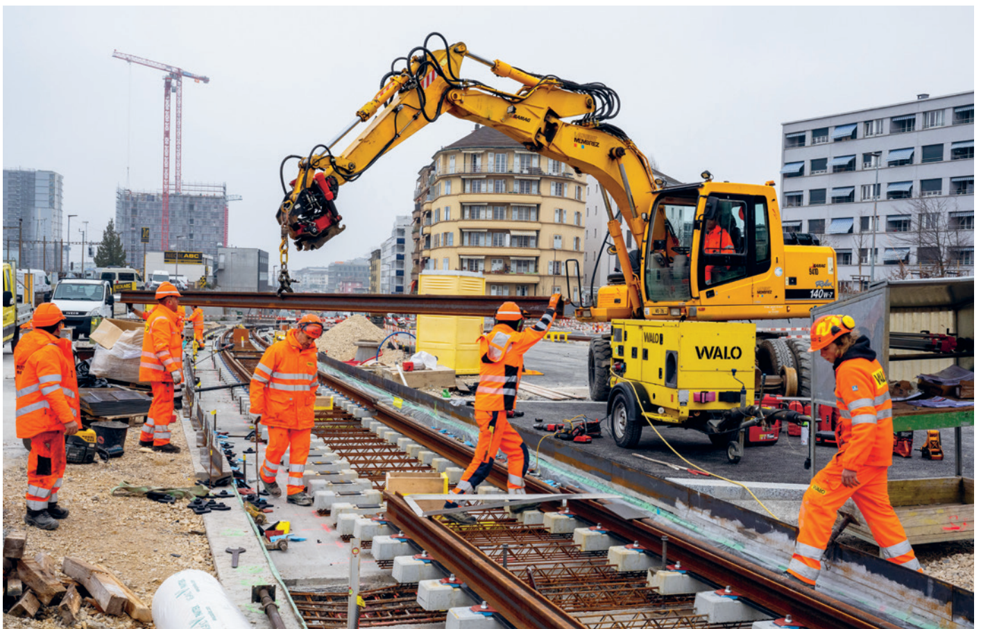
Die Schienen werden auf schwimmende Platten verlegt: Insgesamt sind 50 Unternehmen am Projekt beteiligt.
