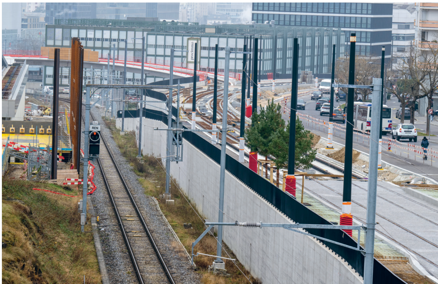
Für die Streckenführung wurden zahlreiche Kunstbauten erstellt: Im Hintergrund die Closel-Brücke, die zum neuen Tramdepot führt.
