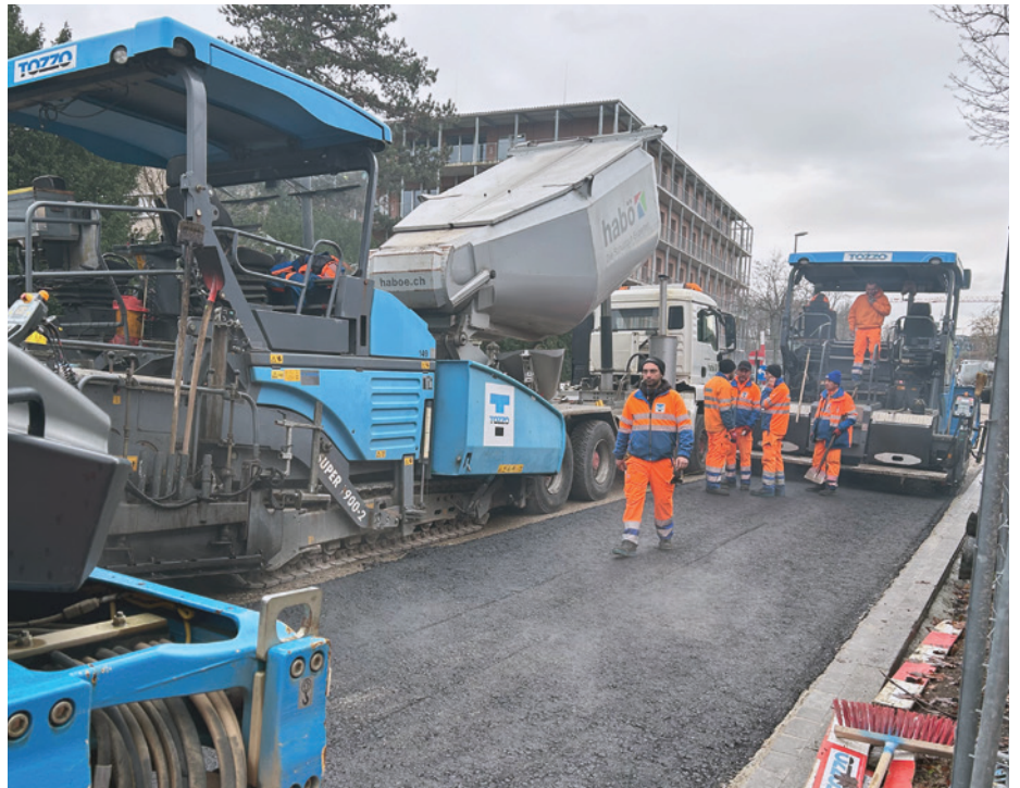
Asphalt mit Pflanzenkohle: Basel setzt das Gemisch auch auf stark befahrenen Strassen – hier die Freiburgerstrasse – erfolgreich ein. Foto: TBA BS
