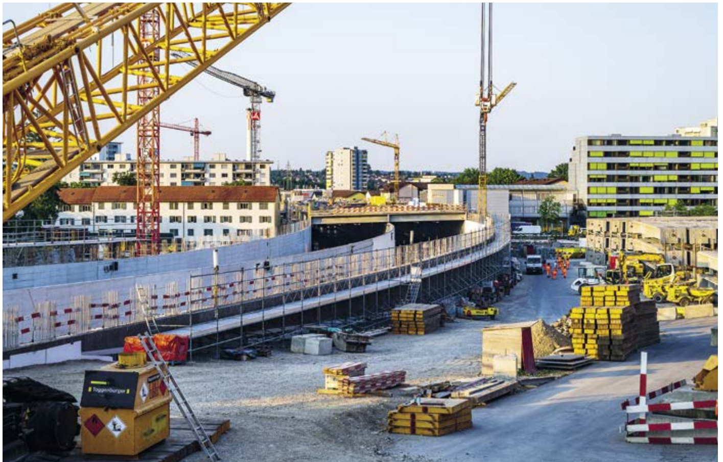
Einhausung der Autobahn: Die Wände sind erstellt, noch fehlt das Dach.
