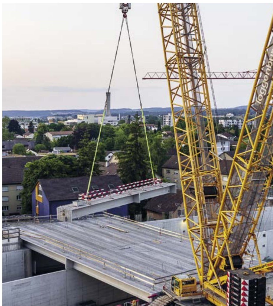
Luftiger Schwertransport: Das Ungetüm von Raupenkran setzt die bis zu 70 Tonnen schweren Betonträger auf die Aussenwände.
