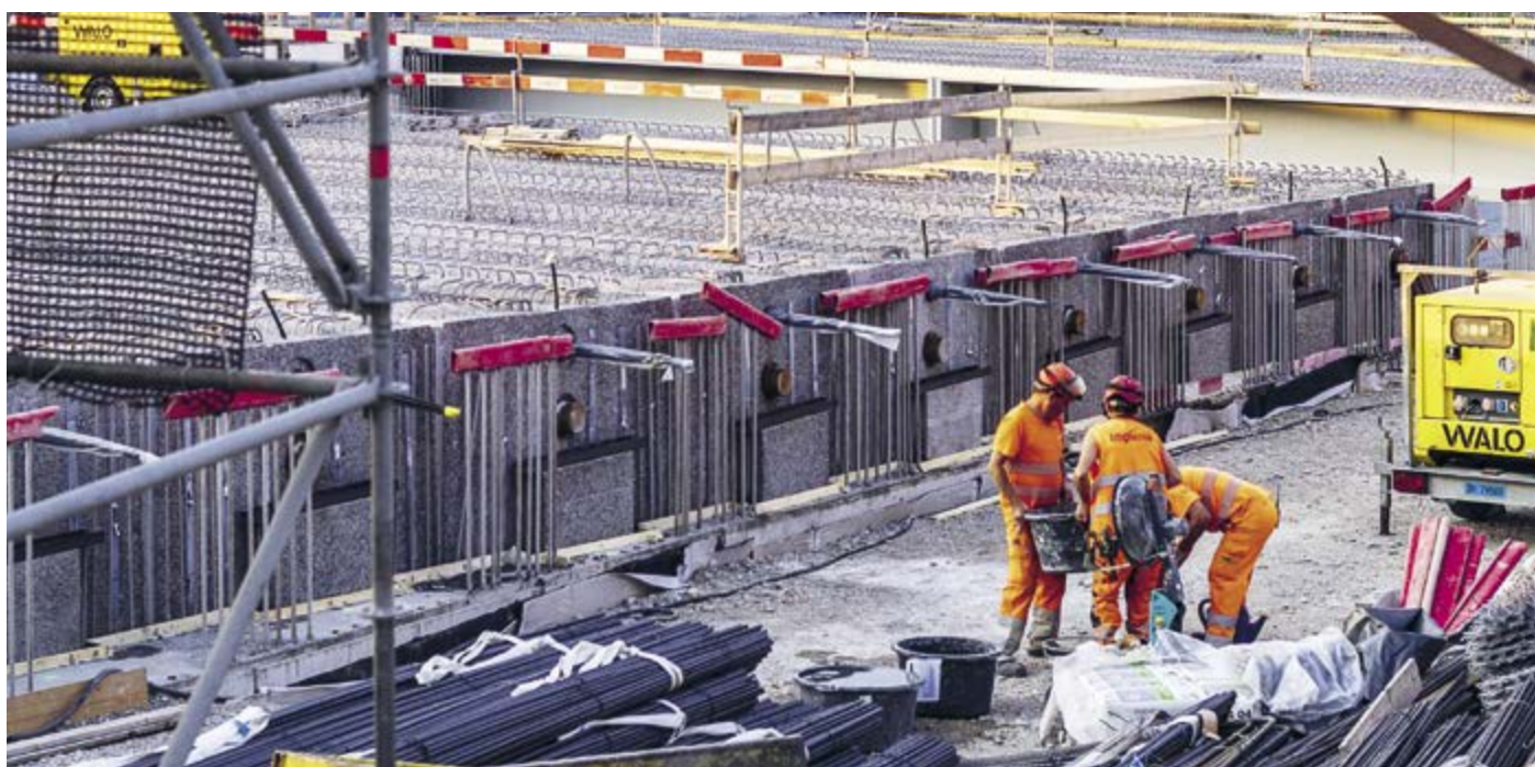
Kaum sind die Betonträger gesetzt, werden sie aussen und innen verschalt und mit Mörtel untergossen.
