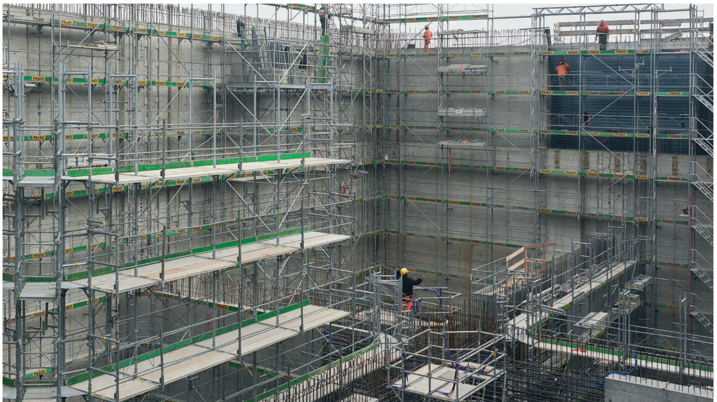
Arbeiten am Abfallbunker: Pro Monat wachsen die Mauern um gut fünf Meter.
