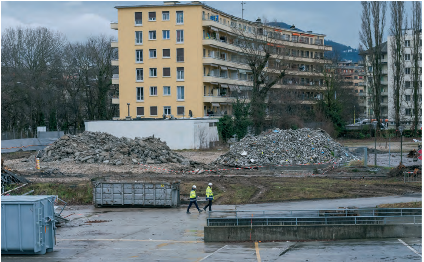
Kurze Wege: Die Materialien werden sortiert und zur Wiederverwendung gestapelt, wo immer dies möglich ist.
