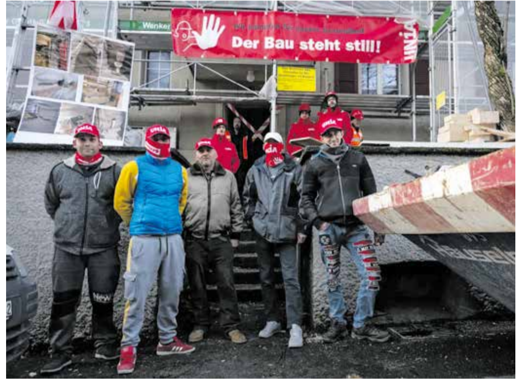
: İnşaat işçileri, Unia sendikası ile birlikte hakları için ortak mücadele ettiler, kazandılar.
