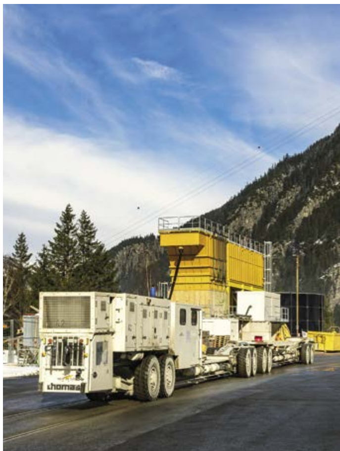
Huit essieux et quarante mètres de long: le véhicule multi-services (blanc) permet d'approvisionner le chantier du tunnel sans rails. Les ouvriers l'utilisent aussi pour se rendre dans la montagne.
