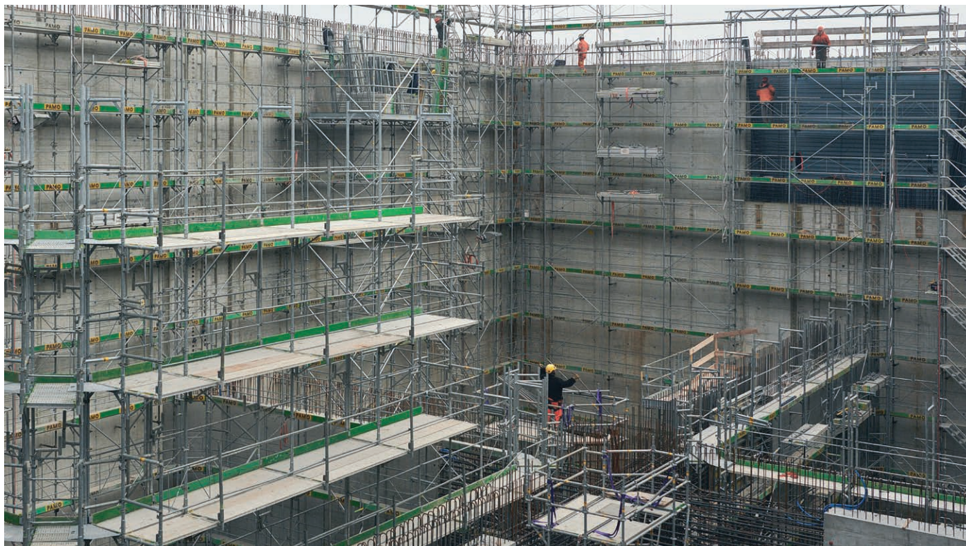
Travail sur le bunker à déchets, qui s'élèvera à 45m de hauteur pour un volume de 70 000m 3 .
