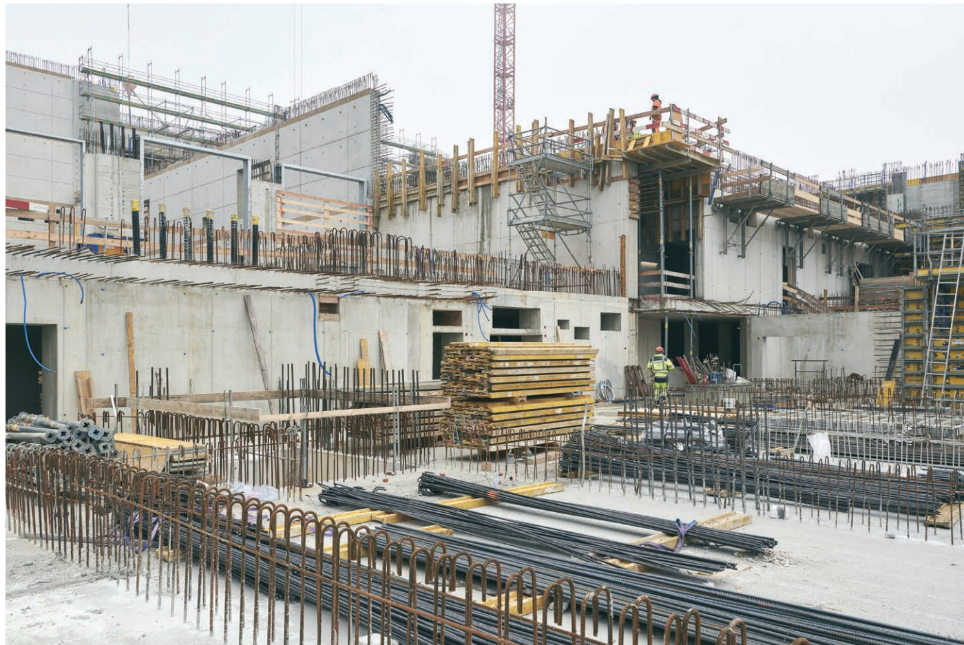
Le chantier exige au total 53 000 m 3 de béton et 6 800 tonnes d'acier d'armature.
