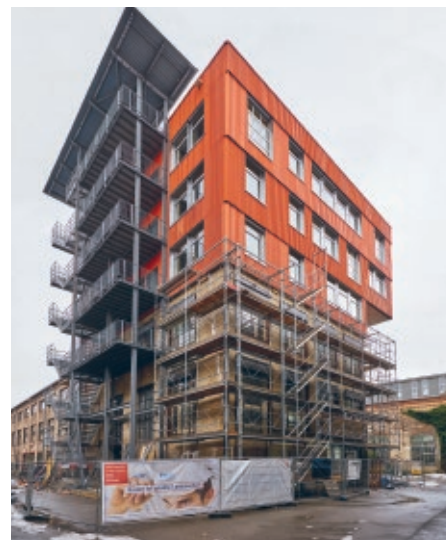
Le chantier du K118 à Winterthour, un modèle pour le réemploi des matériaux.
