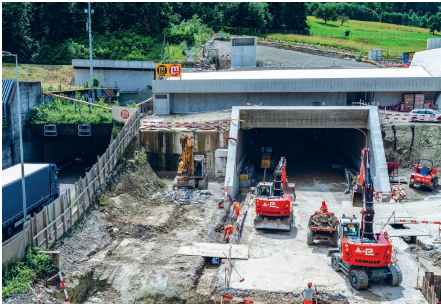
Grand chantier de Zurich nord : le nouveau tube devrait être construit parallèlement à l'une des autoroutes les plus fréquentées de Suisse.
