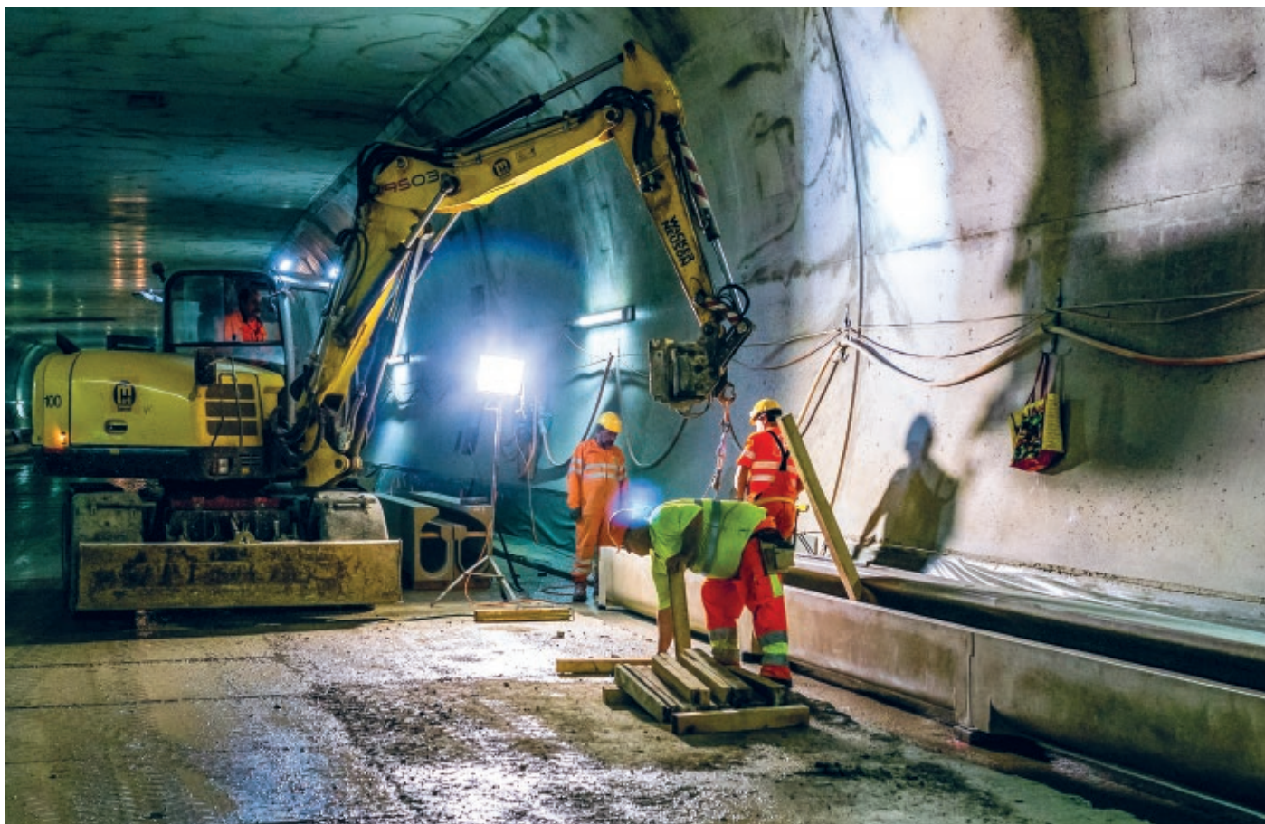
Derniers travaux de soutènement avant de passer le relais aux entreprises chargées des installations d'exploitation et de sécurité : au début de l'année 2023, trois voies de circulation emprunteront le nouveau tunnel.
