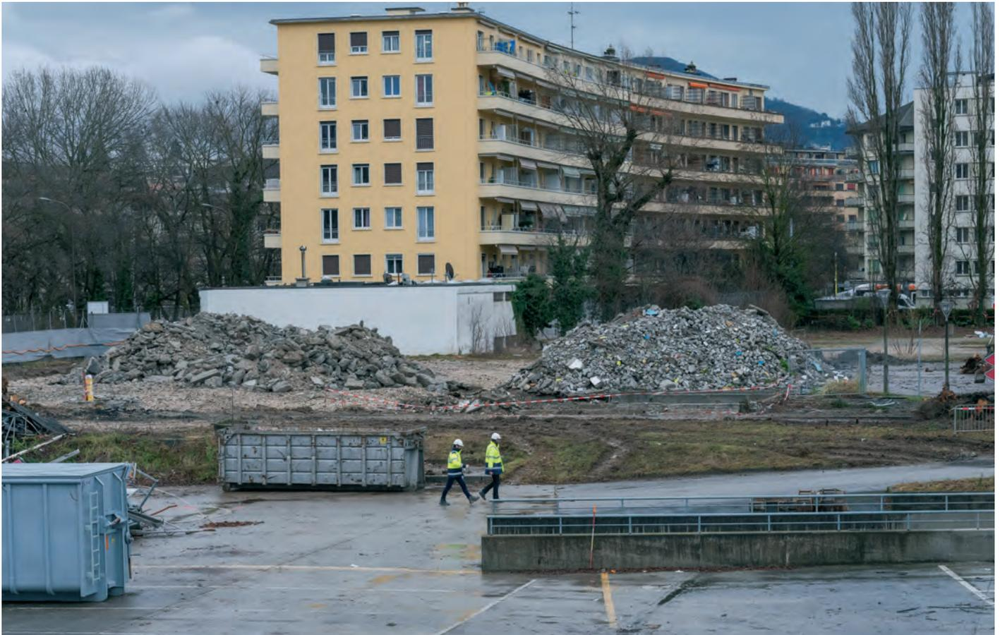
Les matériaux sont triés et rassemblés en tas pour être réemployés ou recyclés dans la mesure du possible.
