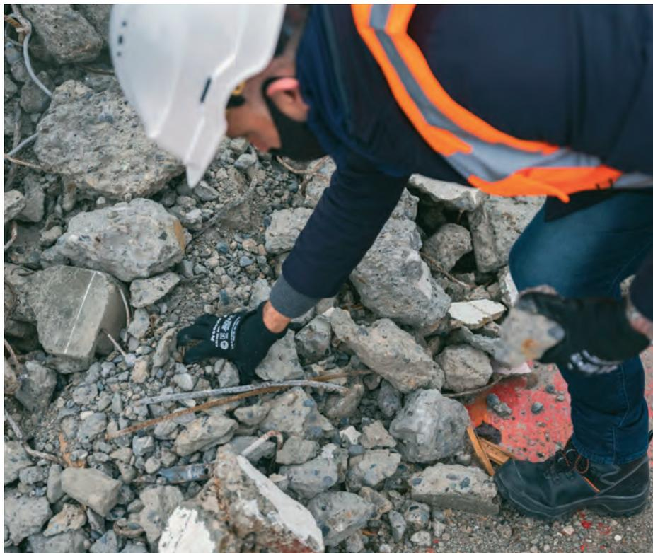
Le béton recyclé sera produit sur place à partir des gravats de démolition. La première étape consiste à séparer le béton des autres matériaux.
