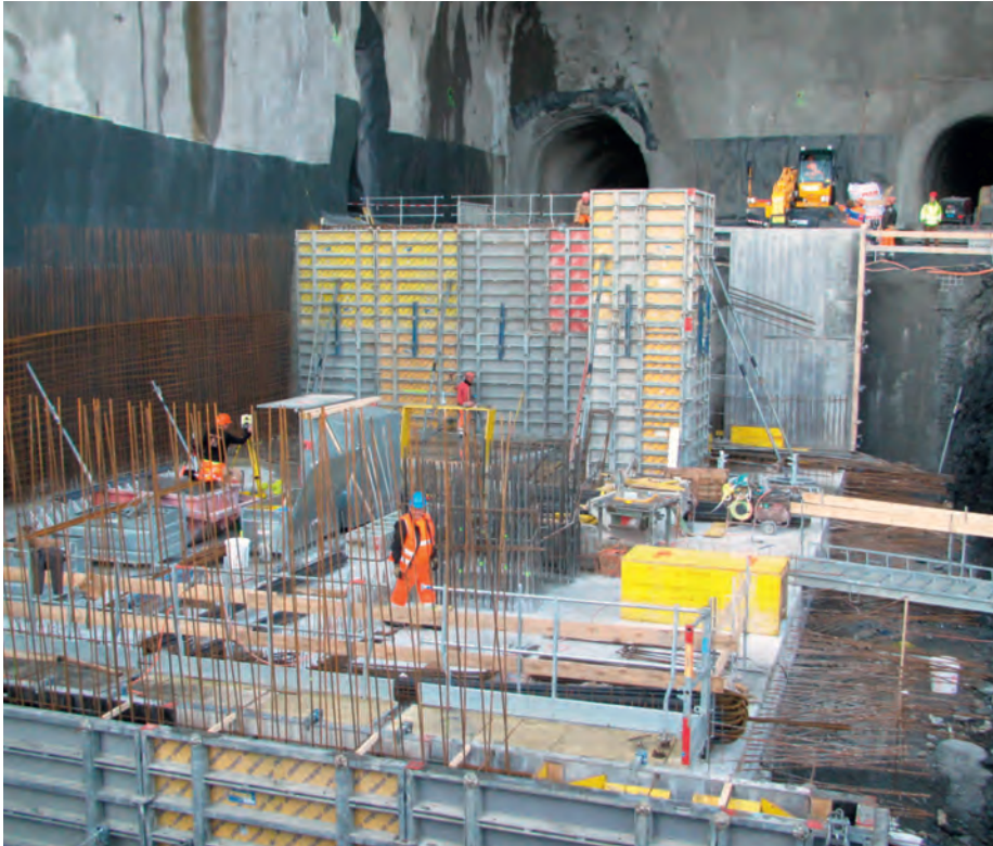
Chantier de la station Eigergletscher: à 2320 mètres d'altitude, 23 000 tonnes de roche ont été excavées par les ouvriers. Photo Jungfraubahnen.
