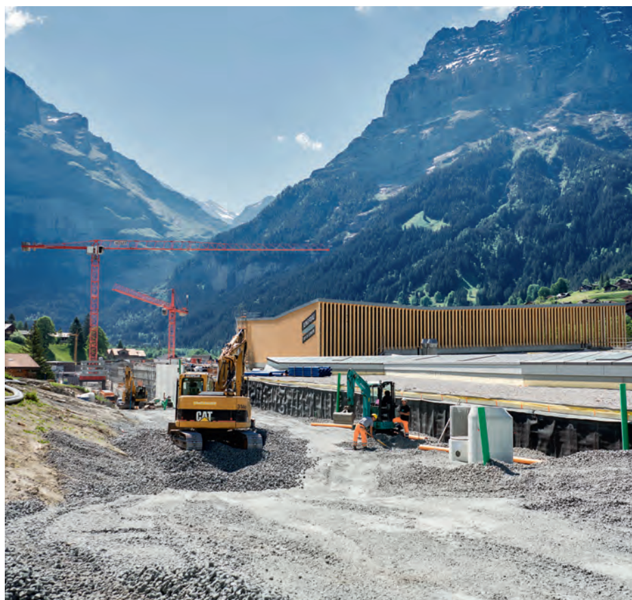
Afin de réduire la pression sur les bâtiments, les ouvriers sécurisent le nouveau terminal en remblayant la fosse avec de l'agrégat de verre cellulaire.
