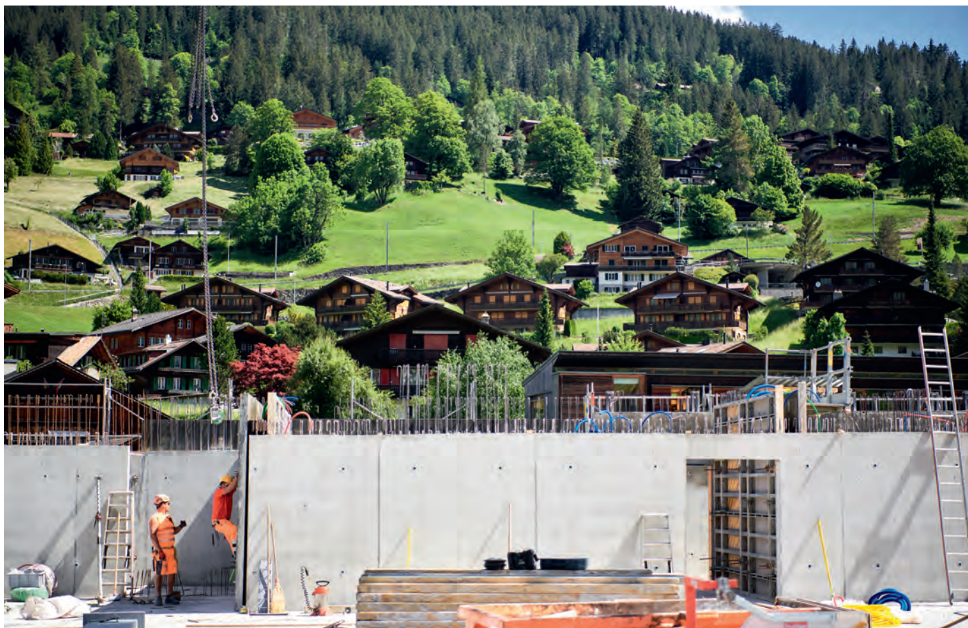
Grand chantier entouré de chalets idylliques. Pour protéger les vacanciers, Grindelwald a prévu un fonctionnement en un seul poste avec une pause déjeuner.
