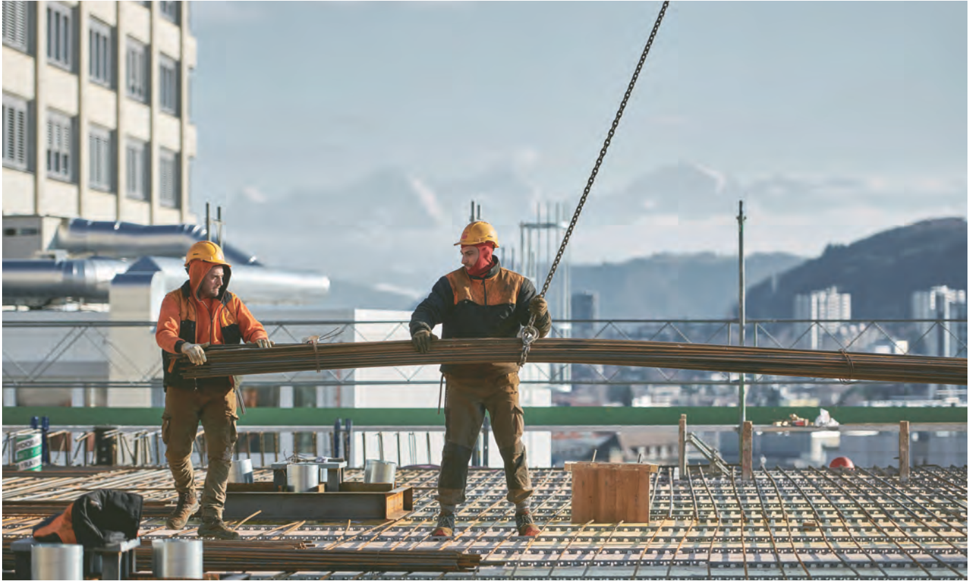
Un chantier offrant une vue panoramique: le nouveau bâtiment principal de l'hôpital de l'île engloutira plus de 56 000 mètres cubes de béton et 8200 tonnes d'armatures.
