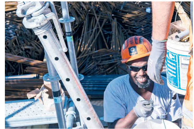
Des processus efficaces: l'acheminement des matériaux est centralisé, tout comme l'évacuation des déchets.
