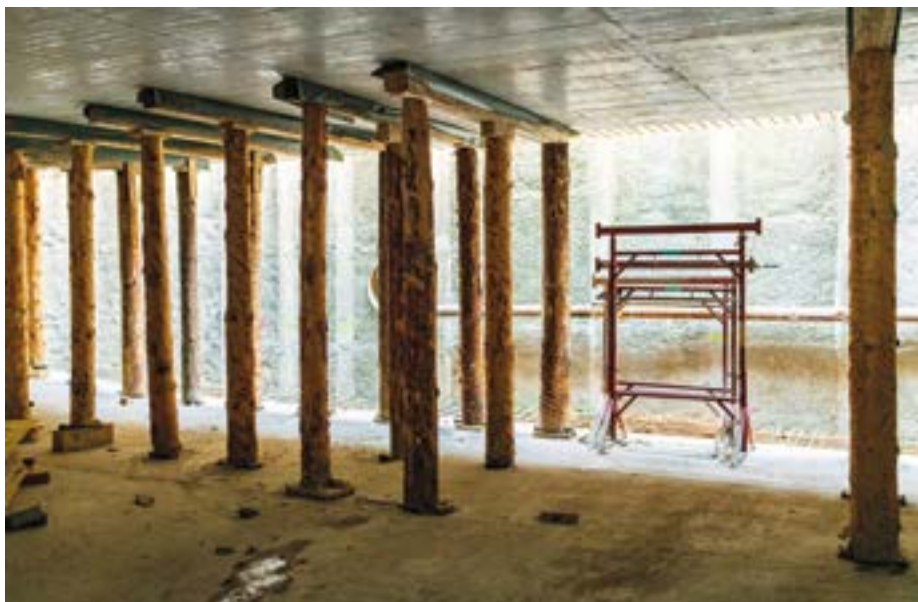
Rampe Konradstrasse: 42 Rundhölzer verleihen dem Raum etwas Wärme.
