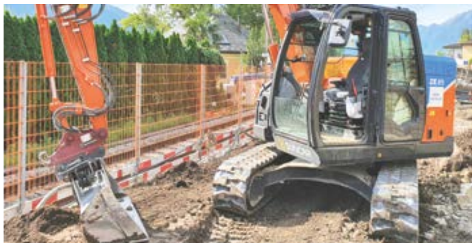
Elektro-Bagger auf SBB-Pilot-Baustelle: «Die Maschinisten waren begeistert.» Foto: SBB
