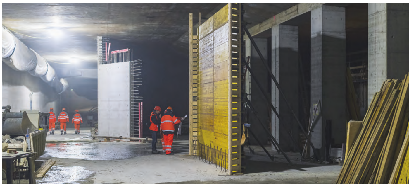
Construit pour les voitures, utilisé pour les vélos: finissage dans le tunnel sous la gare centrale de Zurich.
