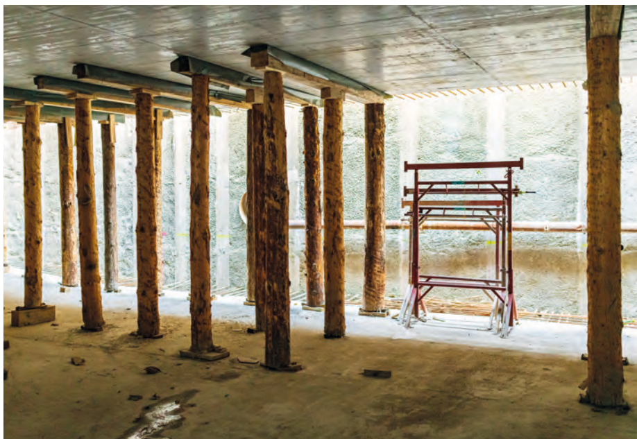
Rampe de la Konradstrasse: 42 rondins de bois confèrent à l'espace un peu de chaleur.
