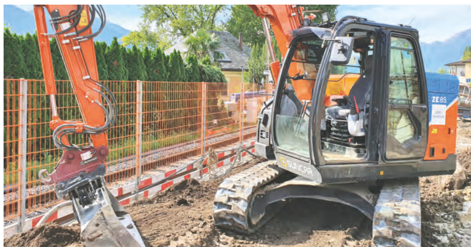
Une pelleteuse électrique sur un chantier pilote des CFF: «Les machinistes étaient convaincus.» Photo: CFF
