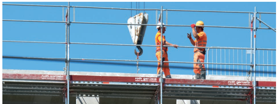
Plus de sécurité grâce à la prévention: sur les chantiers, des prescriptions plus strictes sont entrées en vigueur. Photo: Archives Unia.
