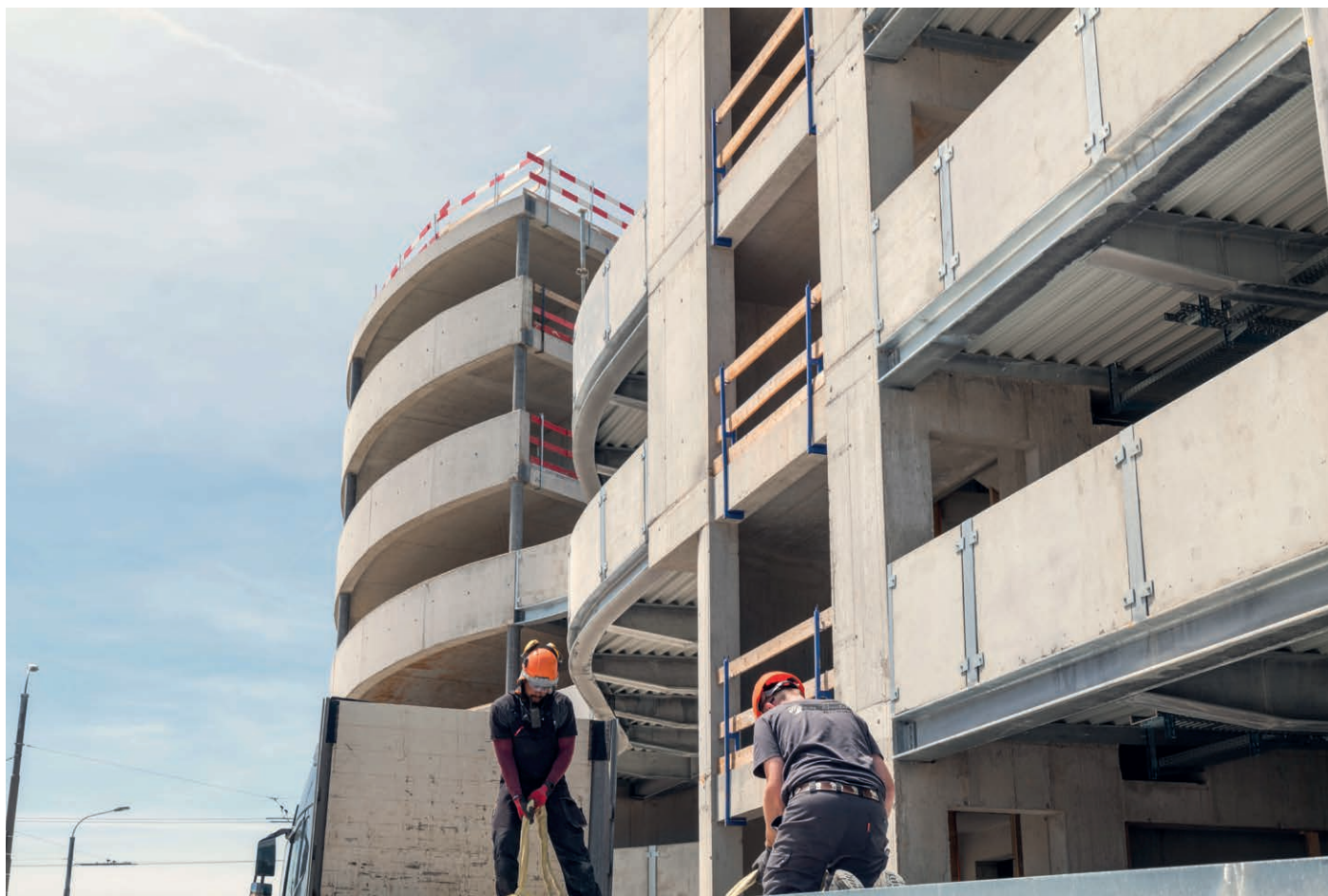
Des ouvriers déchargent des poutres métalliques utilisées pour la construction de la structure du parking aérien à étages.
