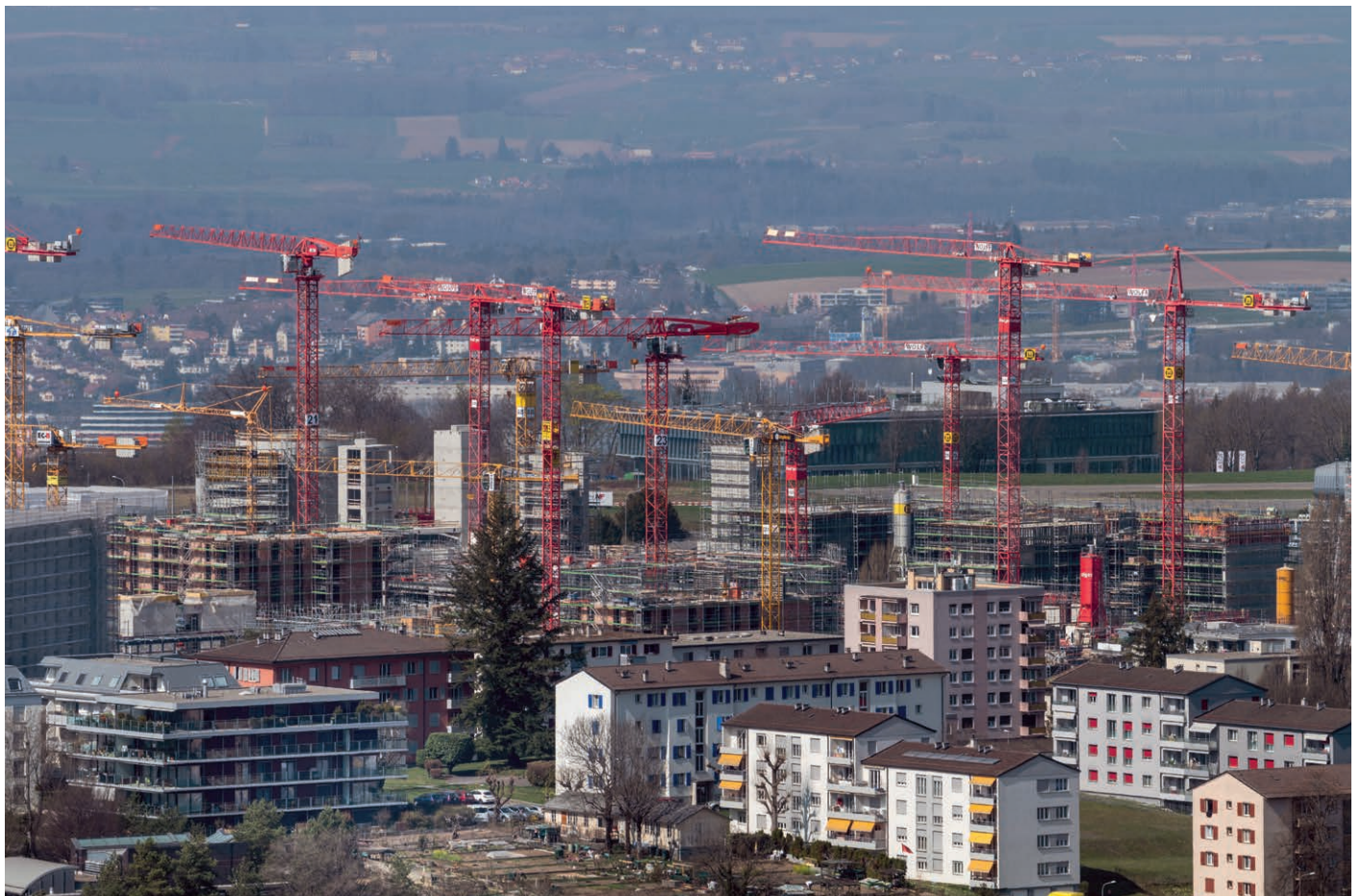
Le quartier en construction des Plaines du Loup se repère de loin par ses nombreuses grues.
