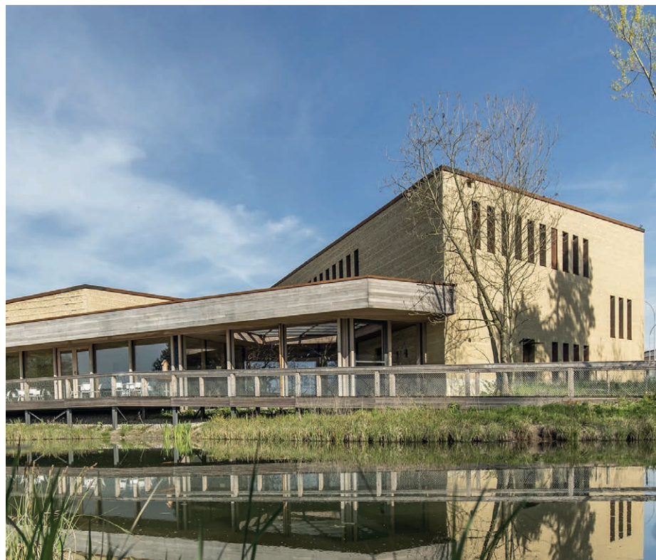
Enveloppe extérieure autoportante en argile pilée: le nouveau centre de visite de la Station ornithologique suisse à Sempach. Photo: Station ornithologique suisse
